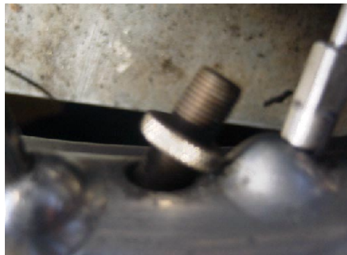
ロックナットを緩めてバルブが横を向くのは要改善
