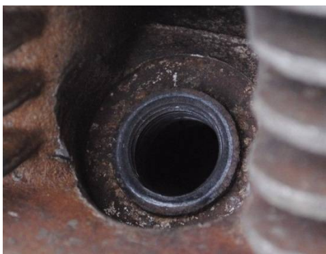
スリーブ浮き上がり傾向
