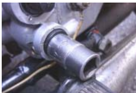
FIG. 05 ソケットを用いて新シール打ち込み
